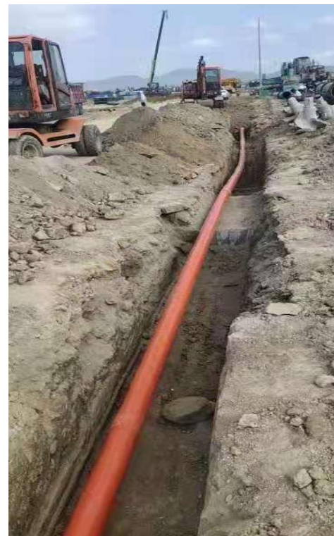
室外电缆管敷设
