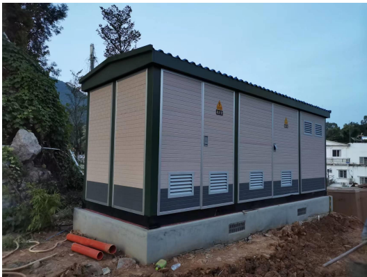
预装式箱变安装
