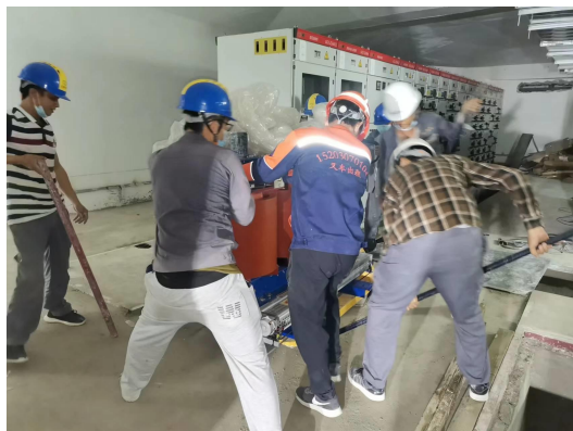
配电房变压器安装
