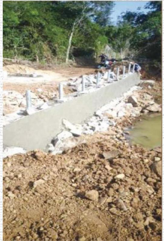
陵水县群英乡南平居船杆村道路及基础设施配套修复工程项目：本项目道路拓宽及硬化总面积为 2034.9 平方米；新建篮球场及配套设施建设面积为 624.7 平方米；盖板暗沟 284米；M7.5 浆砌片石挡土墙为 229.7 立方米；位于陵水县群英乡南平居船杆村。本项目主要目的是加大完善农村道路网络改造，拓宽道路以满足交通需求，新建篮球场，方便群众出行，促进新型社会主义农村建设。
